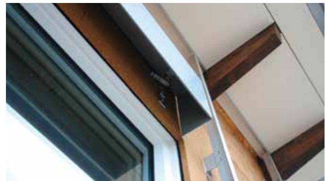
Fensterrahmen-Überdämmung
